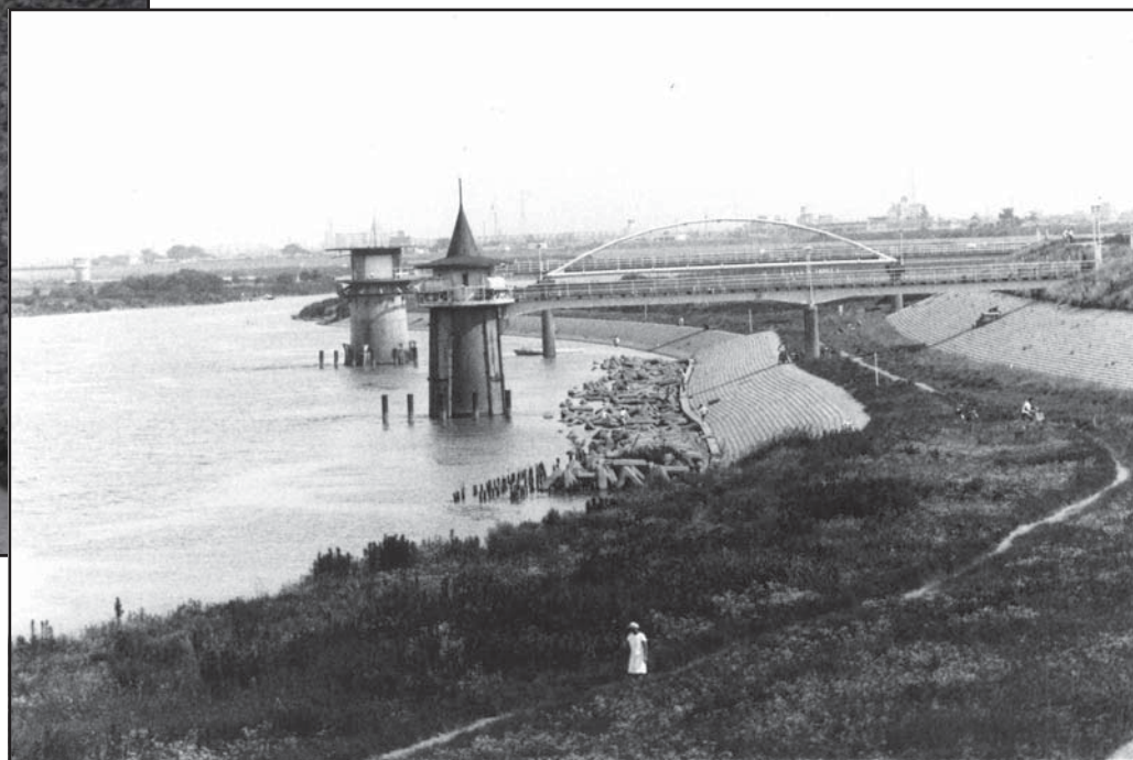
金町浄水場取水塔 大正15年(1926) 給水開始
